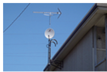
集合住宅や個人宅への アンテナ設置工事
