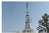
テレビ送信所及び 携帯電話基地局の設備工事
