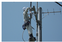
テレビ共同受信設備工事
