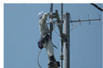
テレビ共同受信 設備工事
