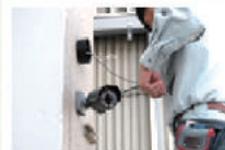
防犯カメラ 設置工事
